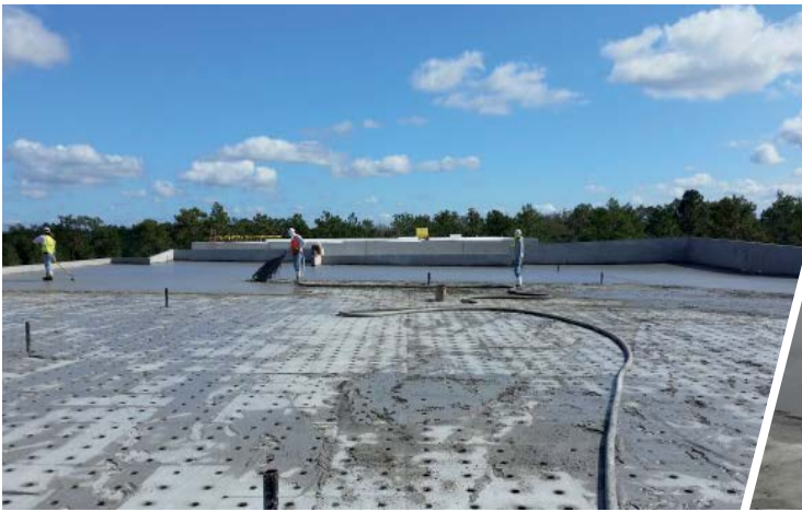
Colocación de Aircreto Celular® sobre las placas de EPS.
