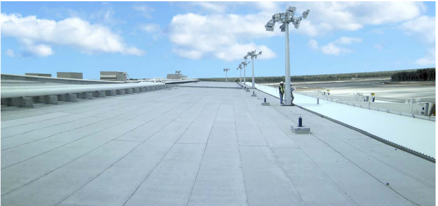
Área terminada impermeabilizada con manto prefabricado Technoply®
