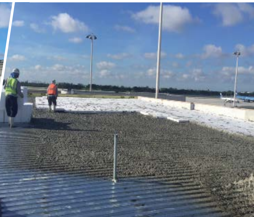
Colocación de placas de EPS sobre Aircreto Celular® y Losacero®
