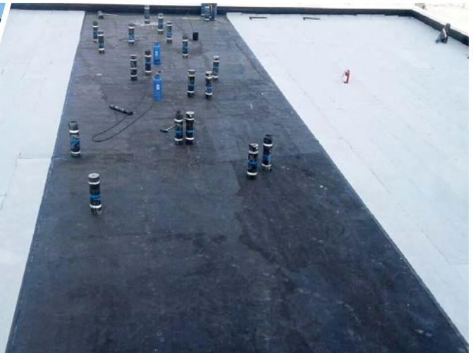
Aplicación de manto prefabricado Technoply®
