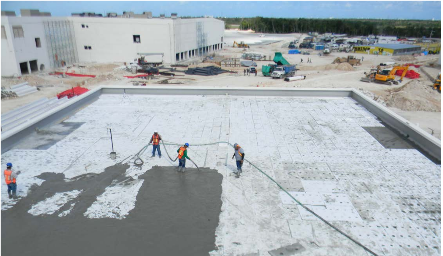
Aplicación de Aircreto Celular® sobre placas de EPS
