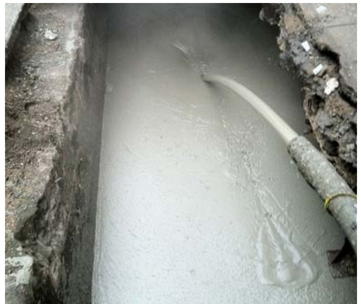
Aircreto Celular® para relleno de trincheras
