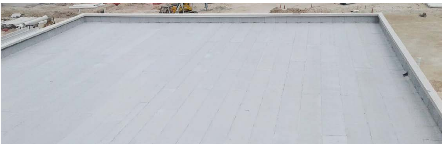
Área terminada impermeabilizada con manto prefabricado Technoply®
