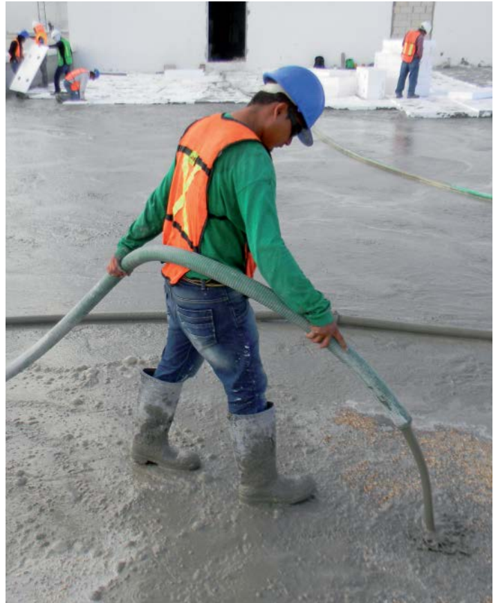
Base de Aircreto Celular® para adherir las placas de EPS
