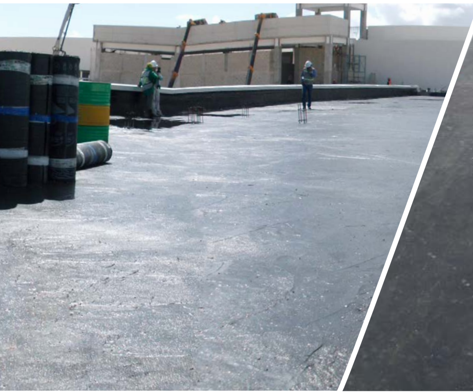
Aplicación de primario asfáltico Primercreto
