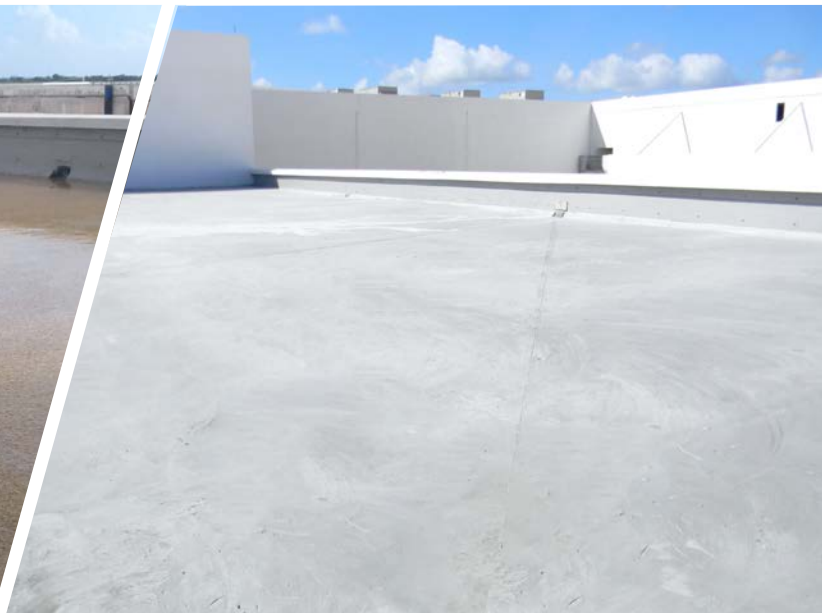
Después: Pendiente creada con Aircreto Celular®
