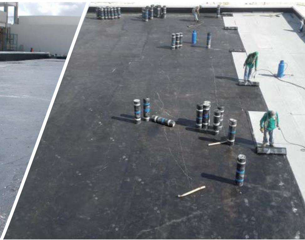
Aplicación de manto prefabricado Technoply®
