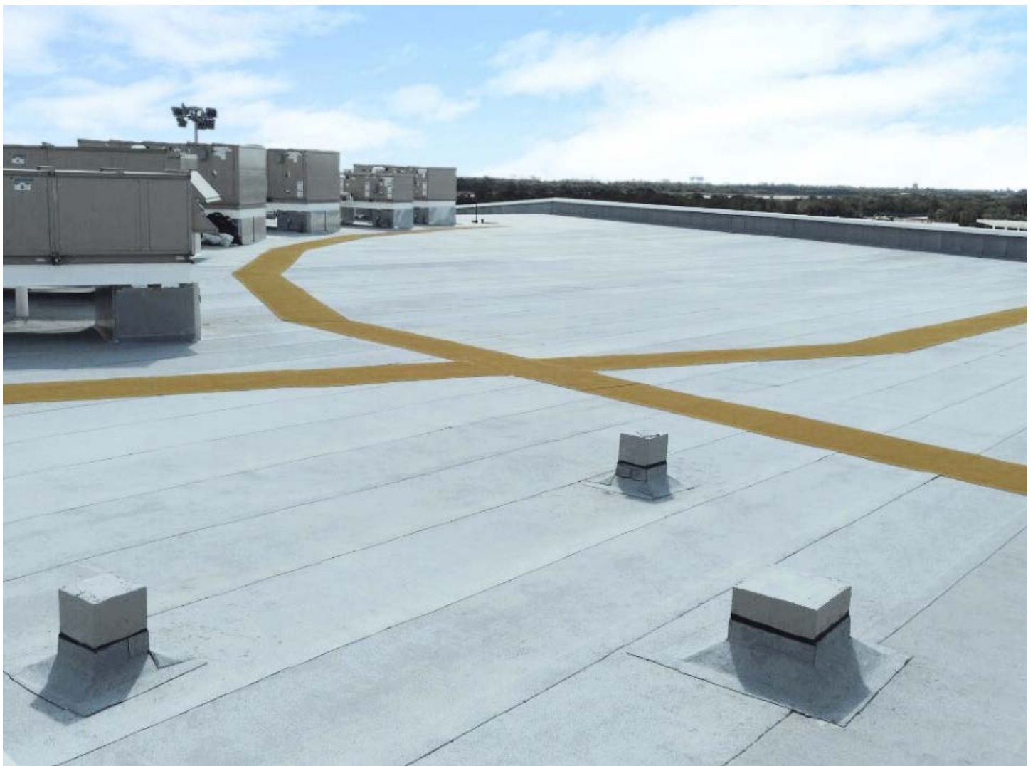
Área terminada impermeabilizada con manto prefabricado Technoply®
