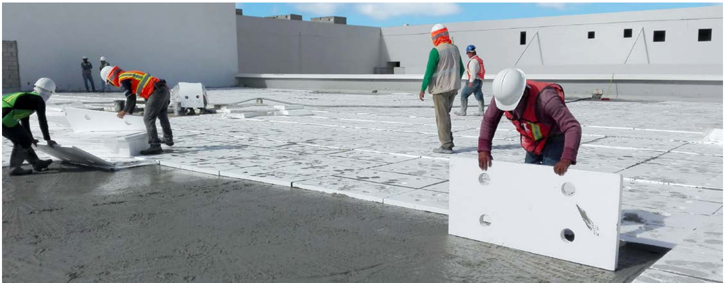
Colocación de placas de EPS sobre una base de Aircreto Celular®
