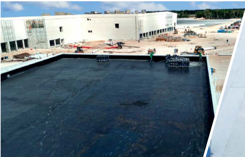
Aplicación de primario asfáltico Primercreto
