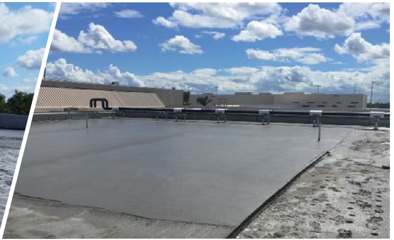
Colocación de Aircreto Celular® sobre las placas de EPS.
