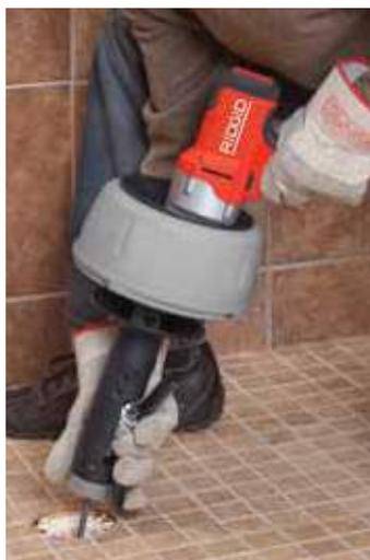
El cable de 3/8" de los modelos K-45AF-5 y K-45AF-7 expande la capacidad de la máquina a líneas de desagüe de 2 1/2 pulgadas.
